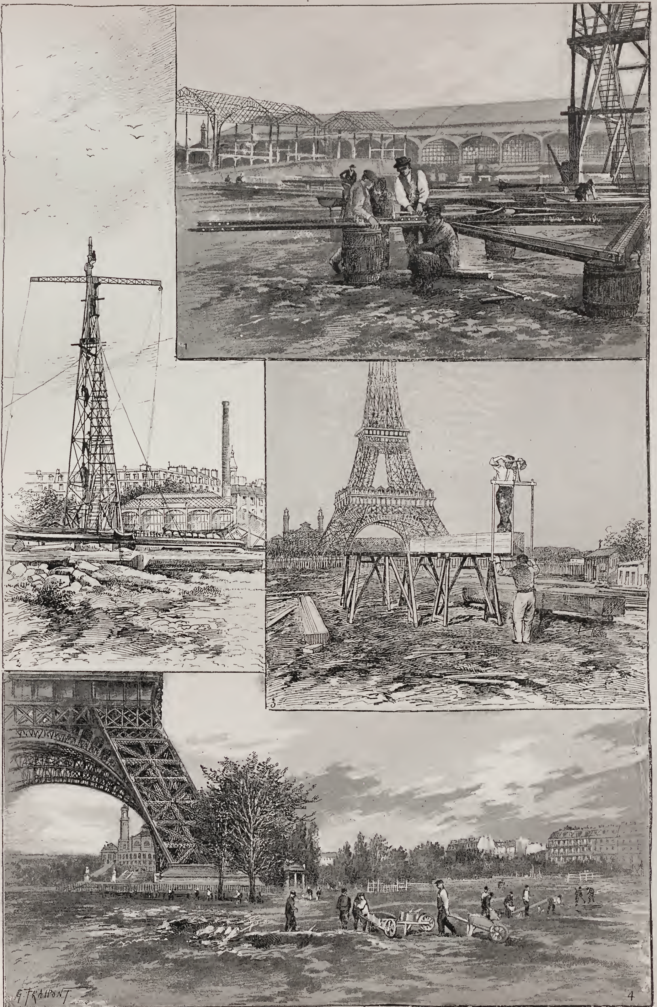
LES CHANTIERS DU CHAMPS-DE-MARS. — 1. Le rivetage. — 2. Une grande grue, à bras mobile. — 3. Les scieurs de long. — 4. Près de la Tour Eiffel: déblayage du terrain.
